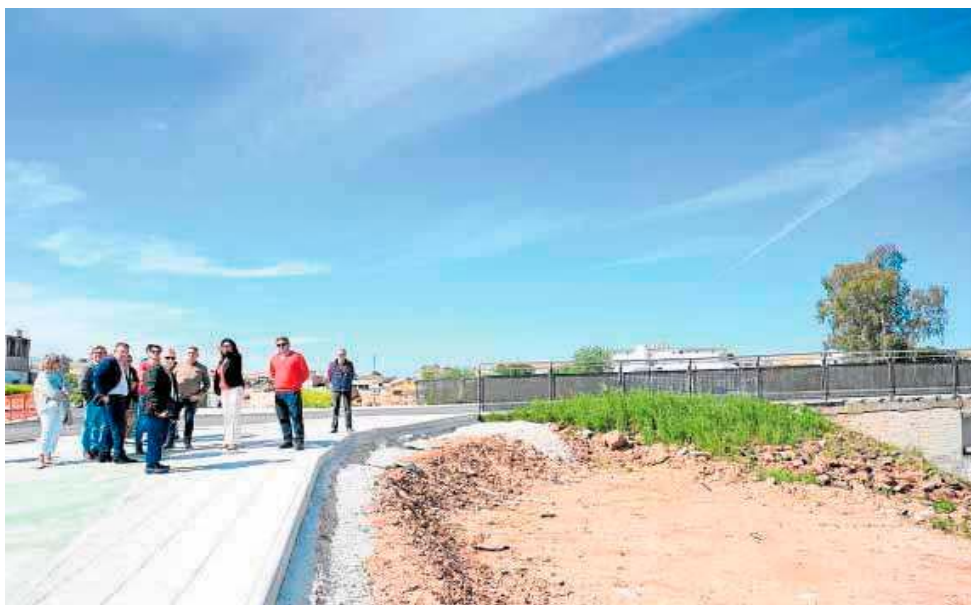
La Comisión de Contratación visita las obras en el Arroyo Periquito Melchor. IDEAL
